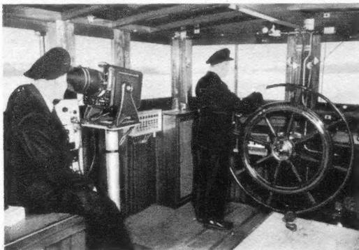
Telefunken/Decca-Radargerät für Binnenschiffe; Sichtgerät im Steuerhaus
